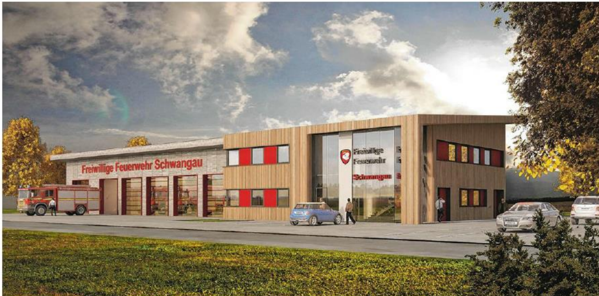
Das neue Schwangauer Feuerwehrhaus ist im Konzept des österreichischen Architekten Thomas Barbist aufgeteilt in Fahrzeughalle (links) und Einsatzgebäude (rechts), das nach vorne versetzt ist und damit eine optimale Übersicht vom Kommandoraum über den Vorplatz ermöglicht. Simulation: Architekturbüro Barbist
